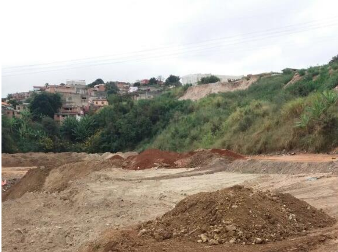
Figura 8.2: Face do talude II, corrigida sem a presença da feição erosiva conforme figura 8.1 de 2016 (fonte Daniel 2017).
