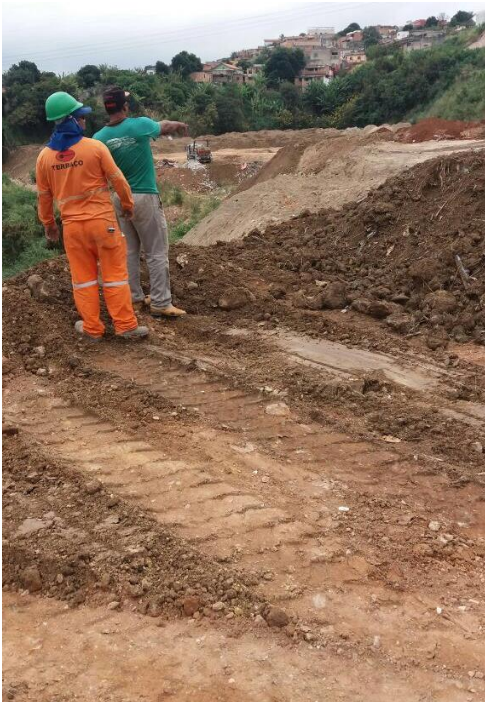
Figura 8.6: Correção dos taludes quanto a compactação e inclinação.
