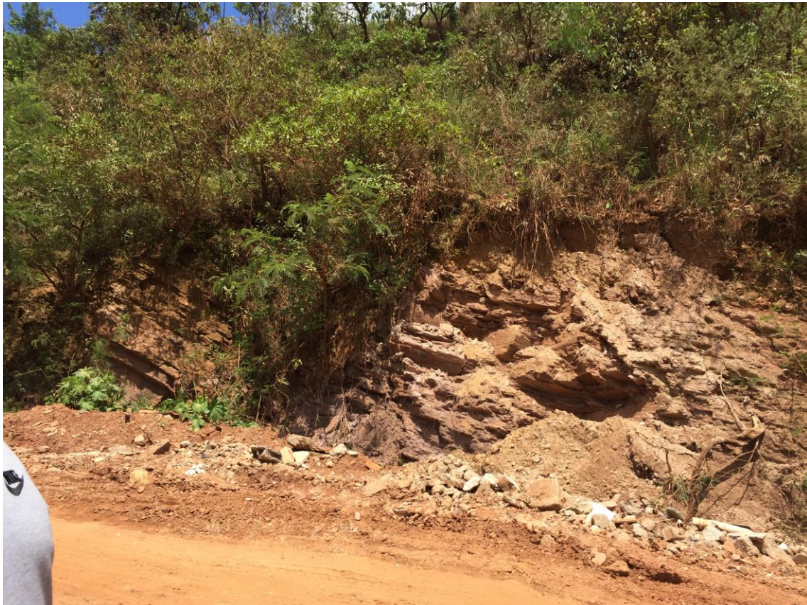
Figura 6.2: Afloramento do gnaíse com xistividade de mergulho aparente contrário ao corte.
