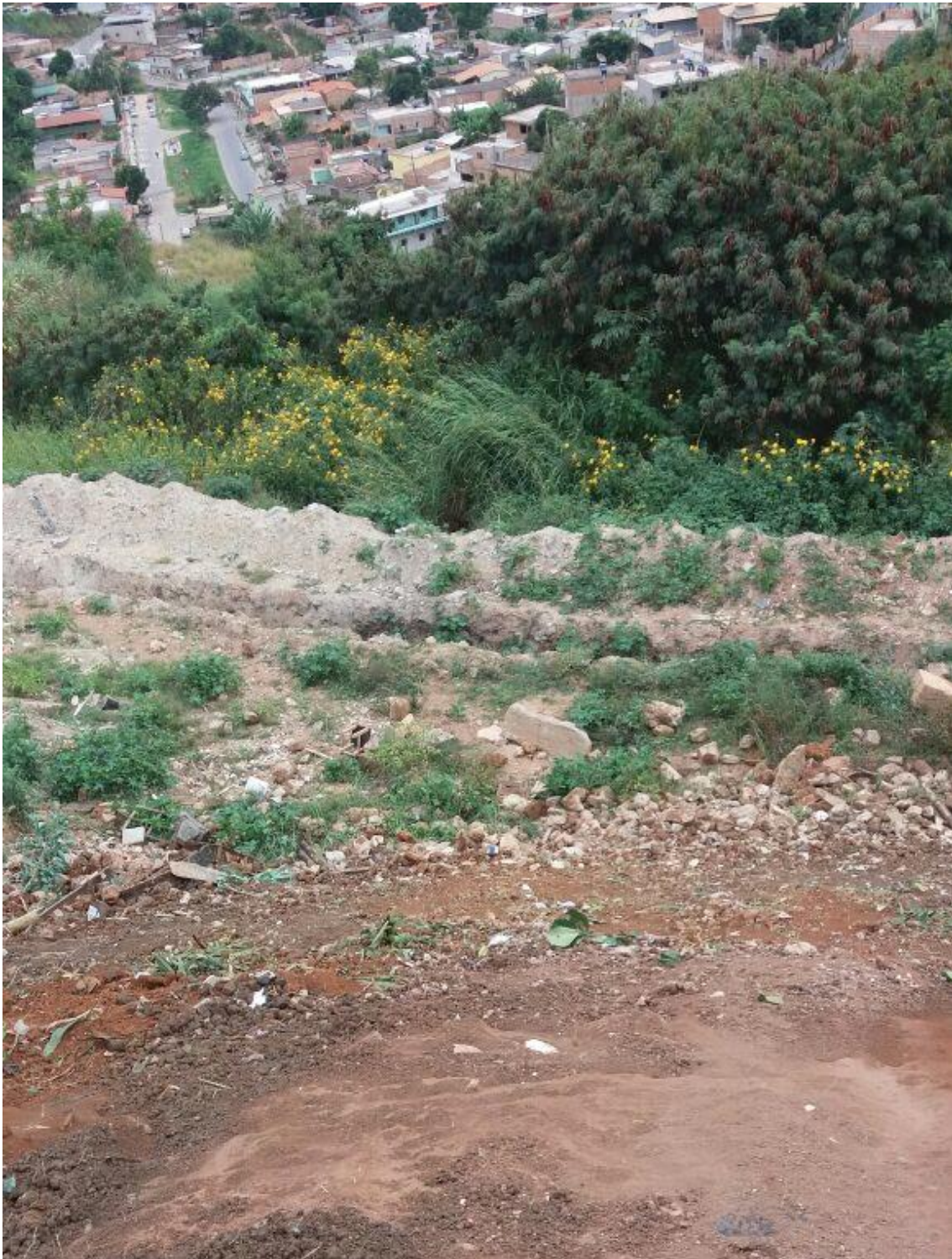
Figura 8.4: Correção das Feição erosiva instalada na face do talude I, que estavam instaladas conforme figura 8.3 (fonte, Daniel 2017).
