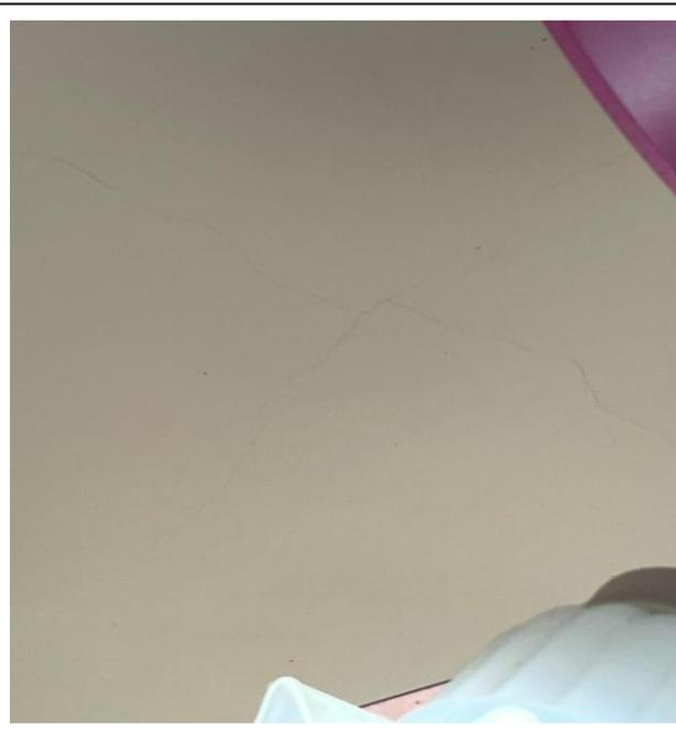
Foto 100 - Apartamento 103 do bloco C – Trincas na parede.
