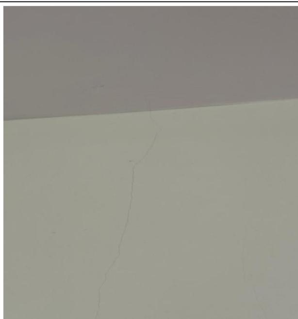
Foto 96 - Apartamento 101 do bloco C – Trincas na parede.
