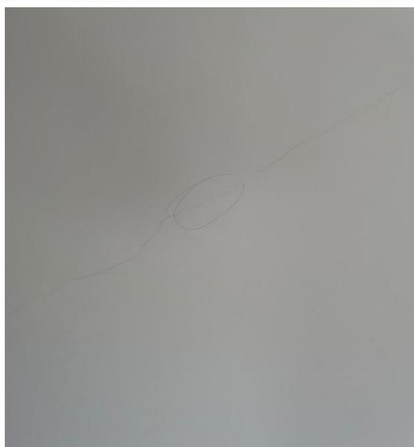
Foto 120 - Apartamento 402 do bloco C – Trincas na alvenaria.
