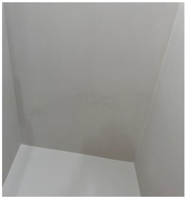
Foto 122 - Apartamento 402 do bloco C – Trincas na alvenaria.
