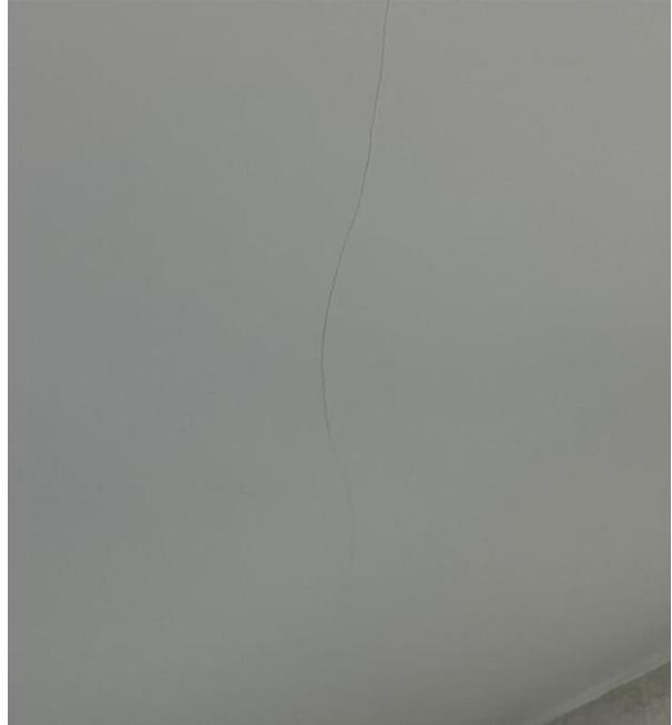
Foto 94 - Apartamento 101 do bloco C – Trincas na parede.
