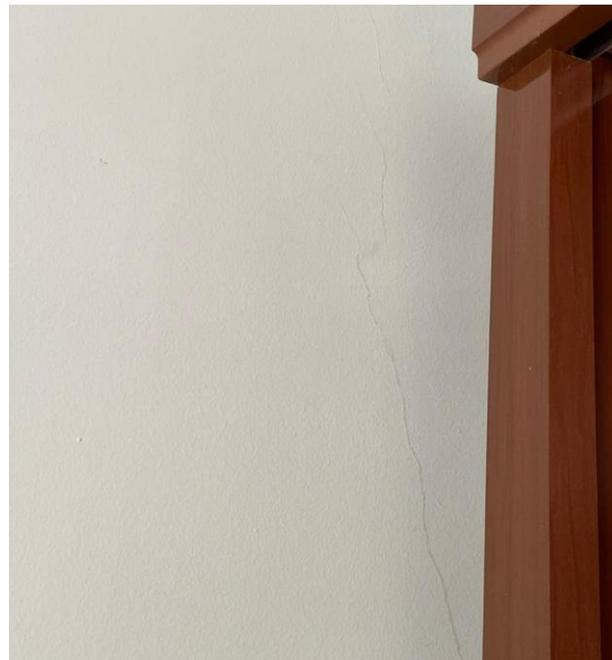
Foto 98 - Apartamento 101 do bloco C – Trincas na parede.
