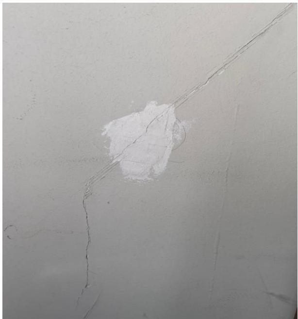
Foto 124 - Apartamento 402 do bloco C – Trincas na alvenaria.
