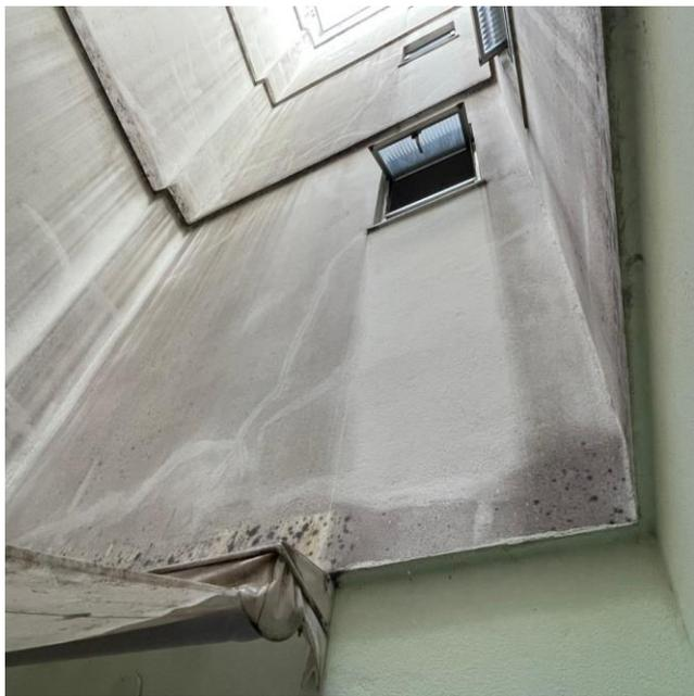
Foto 89 – Vista da fachada do Bloco C com várias trincas.
