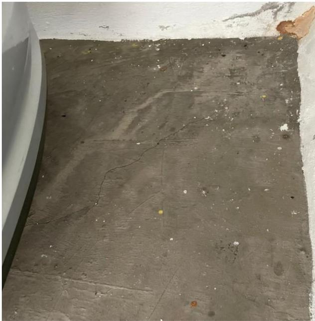
Foto 21 - Trincas no piso da garagem.
