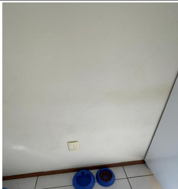
Foto 116 - Apartamento 401 do bloco C – Trincas na alvenaria.
