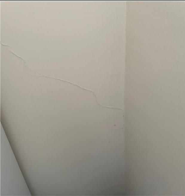
Foto 115 - - Apartamento 401 do bloco C – Trincas próximo a porta.
