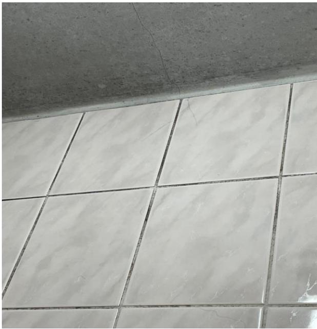
Foto 129 - Apartamento 404 do bloco C – Trincas na cerâmica.
