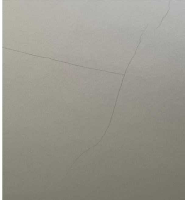
Foto 86 - Apartamento 302 e do bloco B – Fissuras em várias direções.
