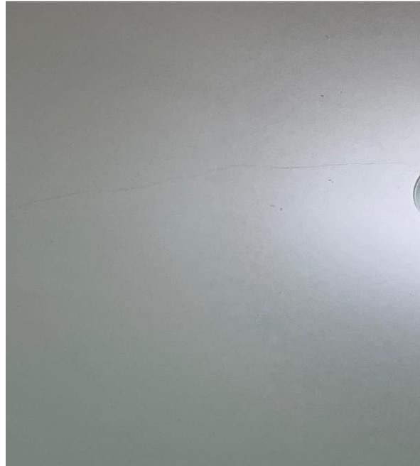
Foto 110 - Apartamento 304 do bloco C – Trincas no teto.
