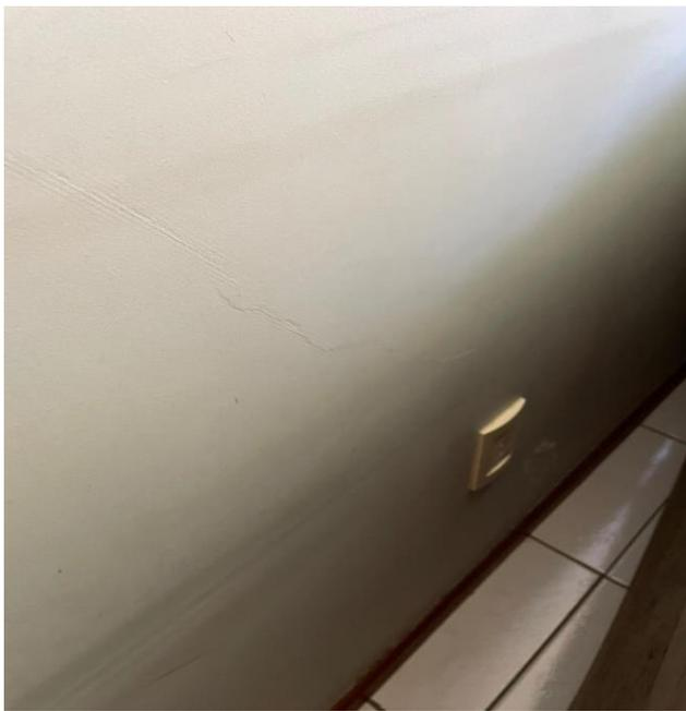
Foto 125 - Apartamento 404 do bloco C – Trincas na alvenaria.
