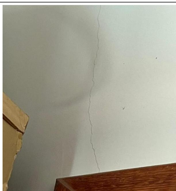
Foto 112 - - Apartamento 304 do bloco C – Trincas próximo a porta.
