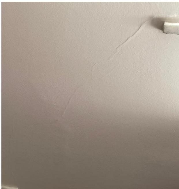
Foto 77 - Apartamento 302 e do bloco B - fissuras no teto.
