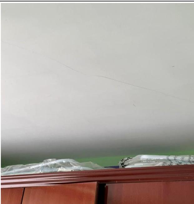
Foto79 - Apartamento 302 e do bloco B - fissuras no teto.
