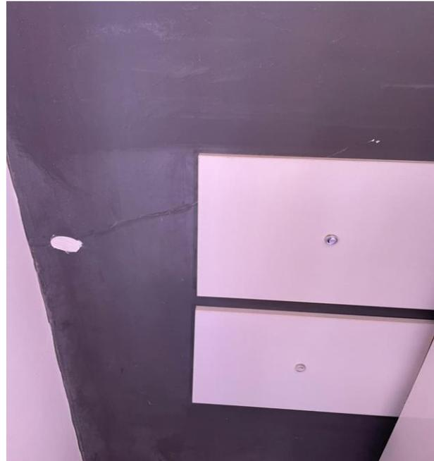
Foto 106 - Apartamento 302 do bloco C – Trincas no parede.
