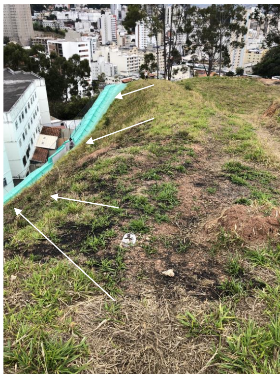
Figura 10.5: Vista de montante para jusante do divisor de águas, com indicação da linha de fluxo das águas pluviais.
