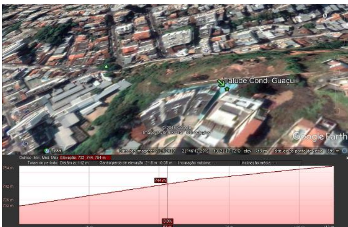
Figura 2.1 – Área do talude (Fonte Google 2018).
